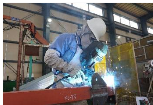
溶接作業の風景
